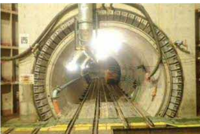
浸水被害を軽減する下水道管整備
