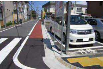
防災生活道路の拡幅整備
