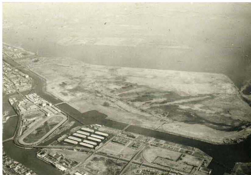
埋立中の大井ふ頭(昭和45年) (写真提供)東京都港湾振興協会
