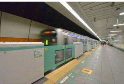
可動式ホーム柵の設置
