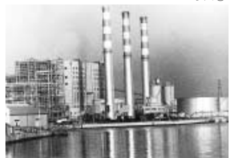
昭和橋から見た品川火力発電所／昭和36年
