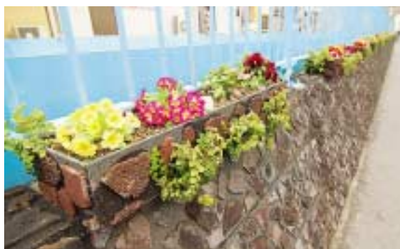
溶岩パネル設置後の護岸。溶岩パネルのプランター側面に植えられたオオイタビが数年後には護岸を緑でおおう予定です
