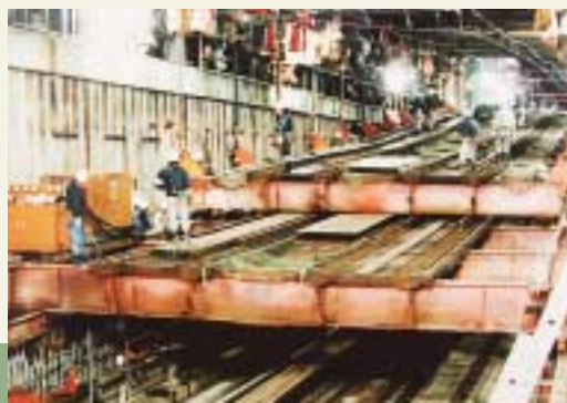
従来の線路を撤去している様子 その下には新しい線路
