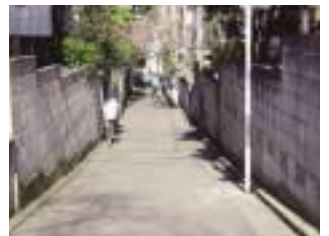
地震の際には倒壊する恐れのあるブロック塀
