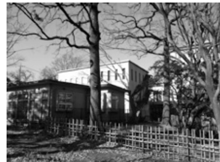
敷地内中央にある建物（撤去予定）
