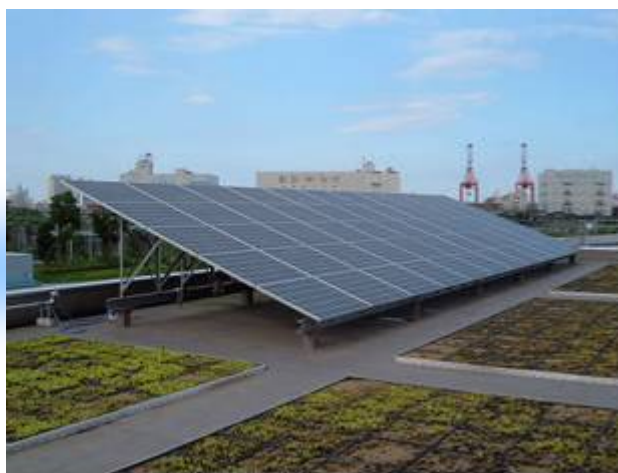
太陽光パネル(品川区資源化センター屋上)
