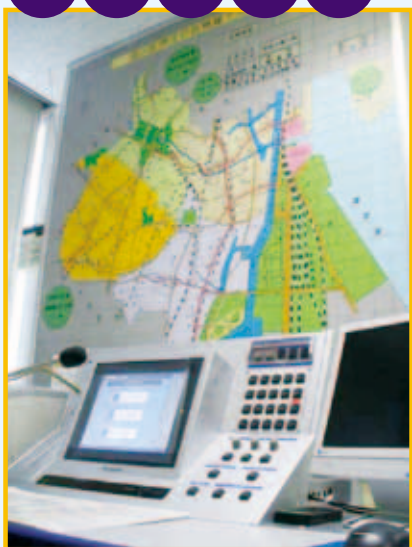
防災行政無線操作卓
