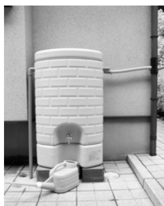
雨水利用タンク
