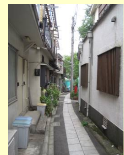
路地に面した住宅地では有効な建物更新が難しく防災上危険な地域もみられる
