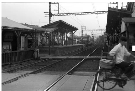
地上に設置された北馬場駅のホーム (昭和40年撮影)
