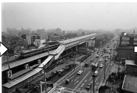
高架化された新馬場駅のホーム (昭和51年撮影)
