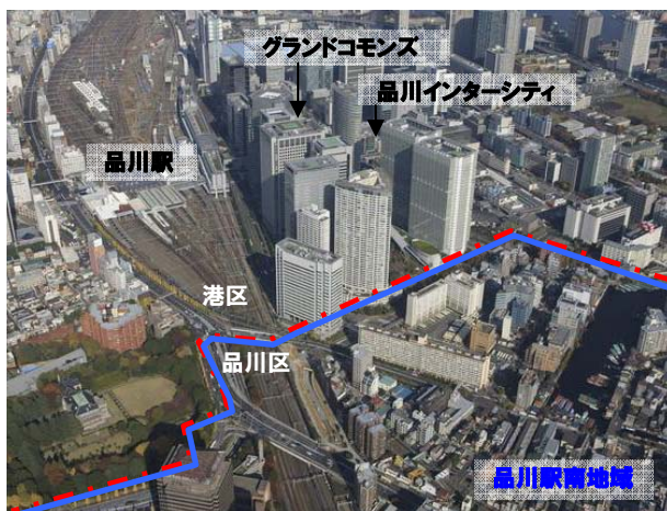
品川駅周辺の都市基盤整備と開発の様子（平成 22 年撮影）
