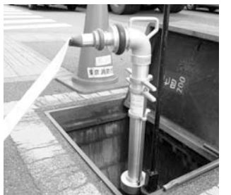
スタンドパイプとは、消火栓とホースを結合し、水圧を利用して消火活動を行う消火器具です。
