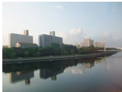
地域冷暖房が導入された八潮団地
