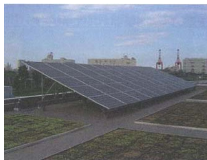
太陽光パネル（品川区資源化センター）
