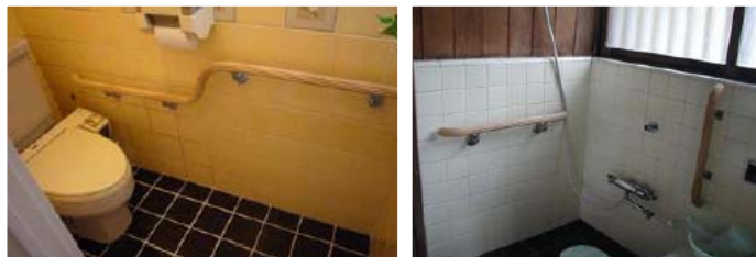
手すりの設置等のバリアフリー工事事例(東京都住宅バリアフリー推進協議会)
