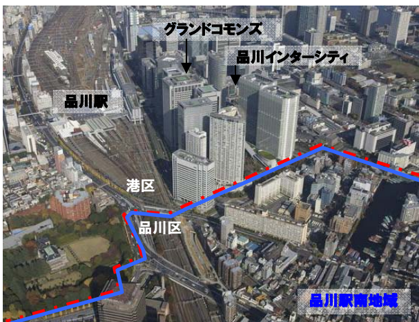
品川駅周辺の都市基盤整備と開発の様子
