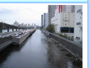
防潮堤が整備された京浜運河沿い
