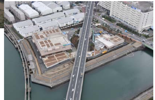
水質改善に寄与する勝島ポンプ所
