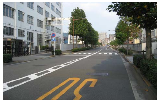
補助 205 号線（整備後：幅員 15m）
