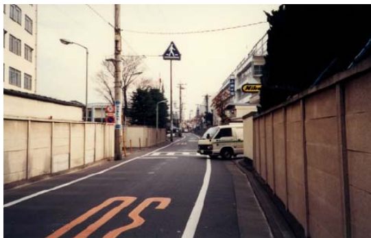
補助 205 号線（整備前：幅員約 9m）
