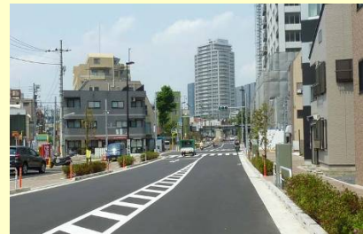
整備が進んだ補助 163 号線
