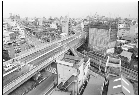
補助 28 号線の大井陸橋(昭和 57 年)
