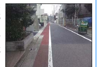
拡幅の進む大原通り
