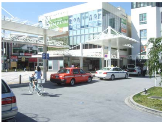
整備された西小山駅前広場
