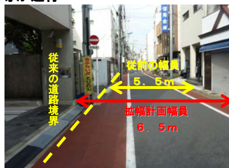
拡幅整備中の富士見通り
