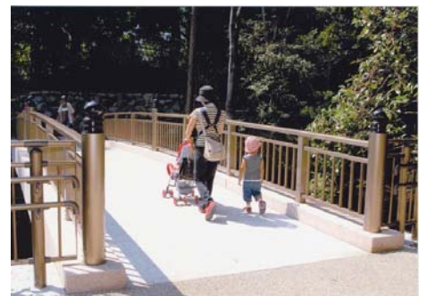
園路のバリアフリー整備(平成19年)
