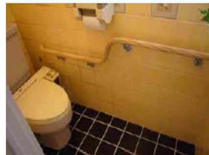
手すりの設置等のバリアフリー工事事例 （東京都住宅バリアフリー推進協議会）
