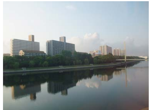
地域冷暖房が導入された八潮団地
