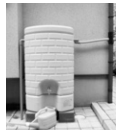
雨水利用タンク
