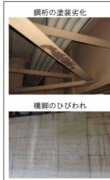
写真 1. 勝島橋の劣化・損傷状況
