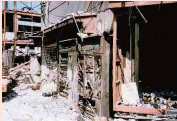
平成7年阪神・淡路大震災の延焼被害の様子 写真出典：財団法人消防科学総合センター〈災害写真データベース〉より
