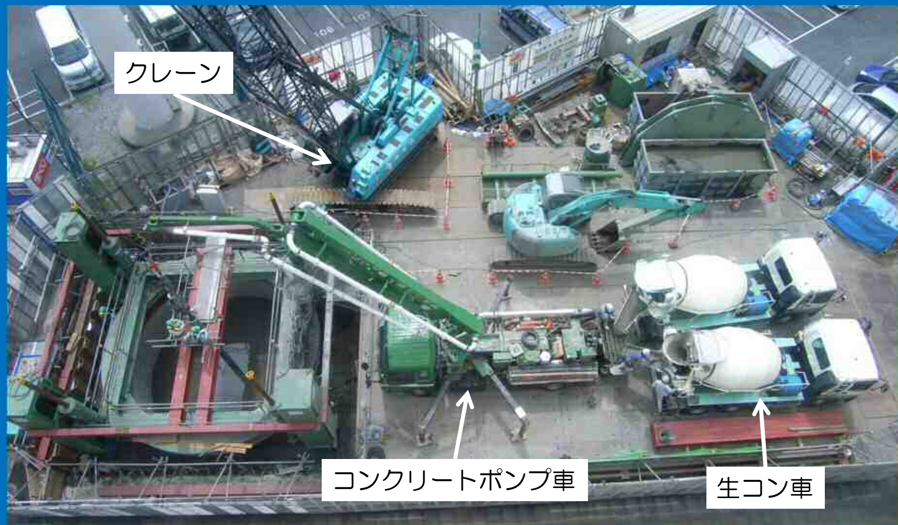
駐輪場本体工 コンクリート打設イメージ写真(施工例)
