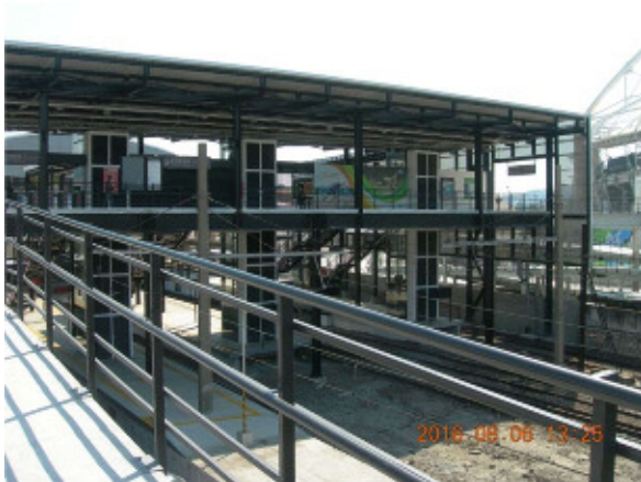
ホームからのエレベーター
