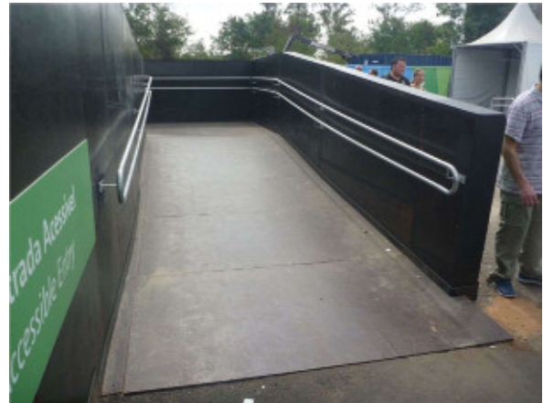
ホッケー会場の仮設スロープ（木製床材）
