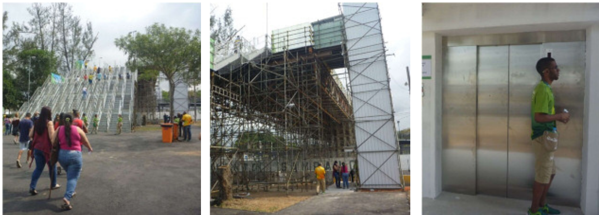
会場間をつなぐ大きな仮設階段と仮設エレベーター
