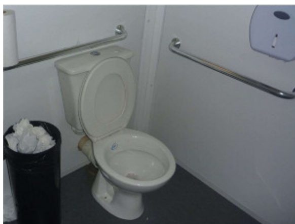
障害者用トイレ 内部
