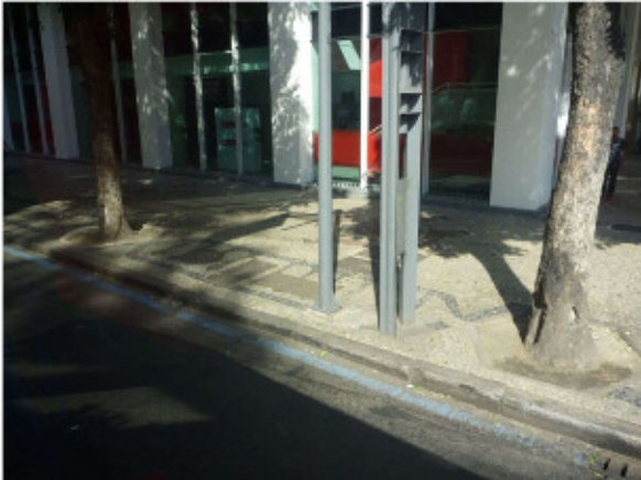
街渠（側溝）の状況
