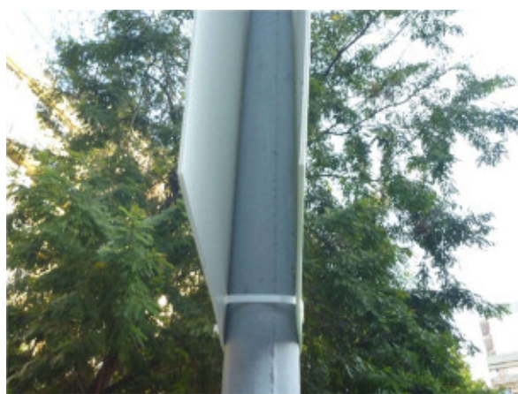
簡易な仕様のサイン（材料と留め方）
