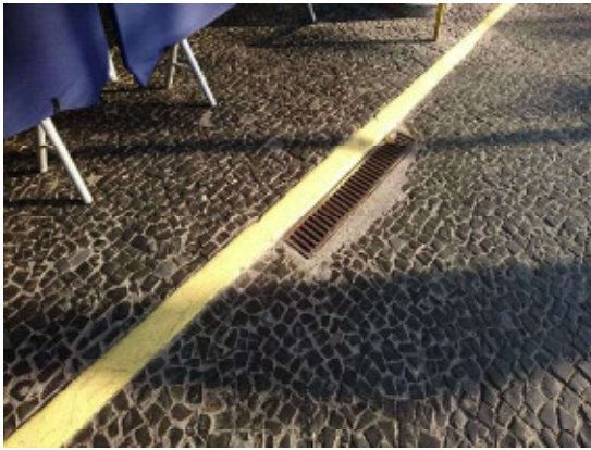
写真 2-15 中心市街地の雨水溝の様子 筆者撮影
