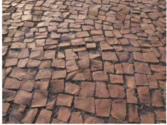
写真 2-92 敷地内遊歩道の路面 筆者撮影
