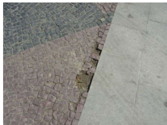
写真 2-28 路面の現状 4 筆者撮影
