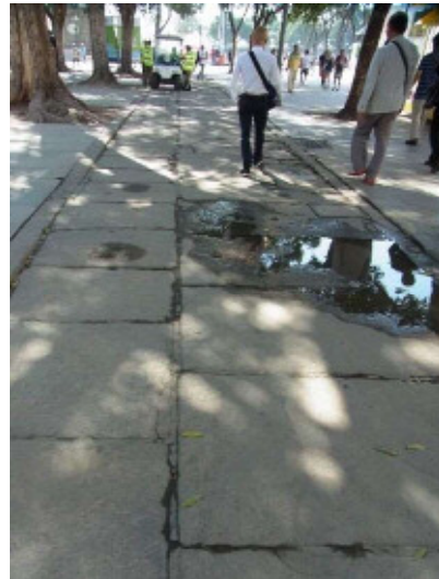
写真 2-26 路面の現状 2 筆者撮影
