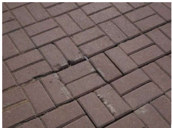
写真 2-75 路面の劣化 筆者撮影
