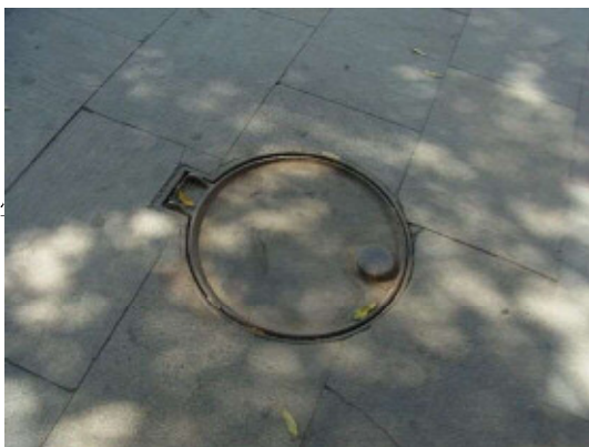
写真 2-27 路面の現状 3 筆者撮影
