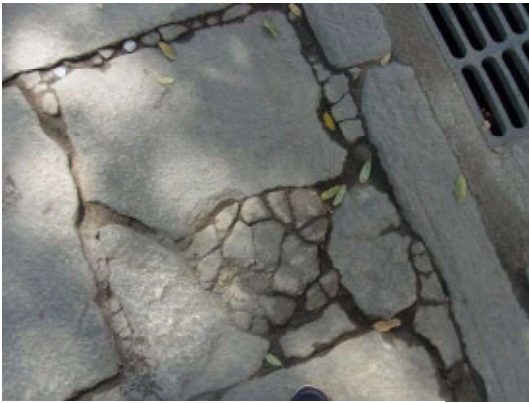
写真 2-25 路面の現状 1 筆者撮影
