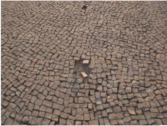
写真 2-91 敷地内遊歩道の路面 筆者撮影
