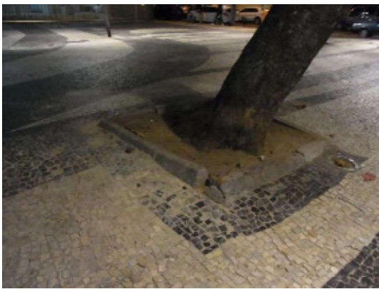
写真 2-180 劣化した歩道 筆者撮影
