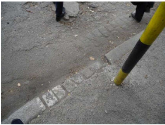
写真 2-148 劣化した道路 筆者撮影
