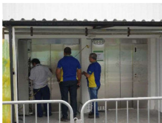
写真 2-163 修理中のエレベーター 筆者撮影
