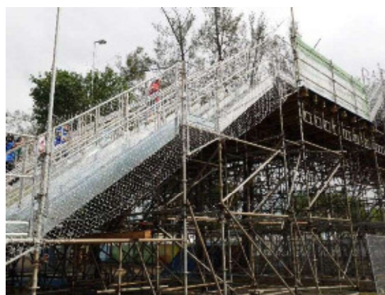
写真 2-161 仮設橋の構造 筆者撮影
