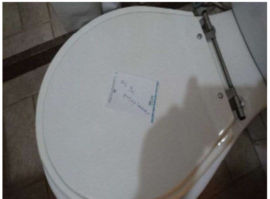
写真 2-194 詰まったトイレ 筆者撮影
