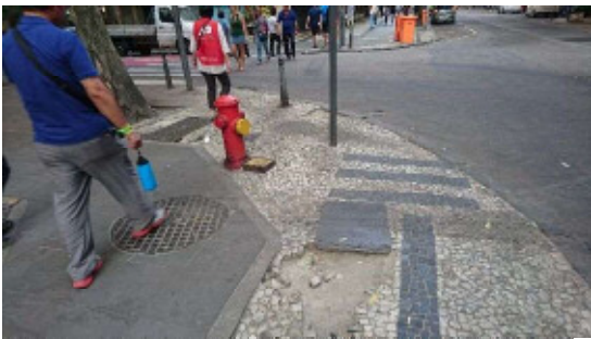
写真 2-234 劣化する歩道 筆者撮影
