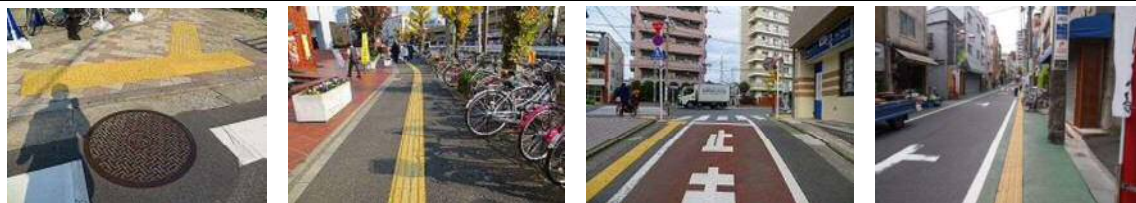
左から：横断歩道のすりつけ勾配がきつい、路上駐輪、縦断勾配がきつい、点字ブロック付近に店看板
