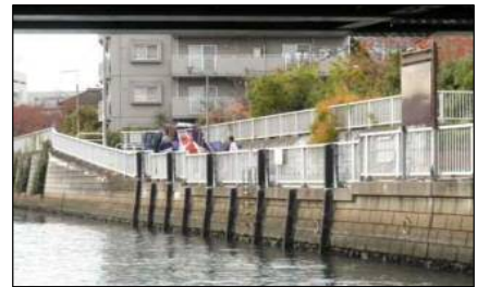
東海橋防災船着場
