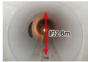
▲浜川雨水排水管 (29年度完成) (直径: 約2.8m、延長: 約750m)
