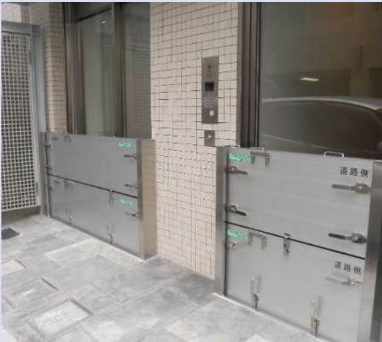
図 23 防水板の設置事例
