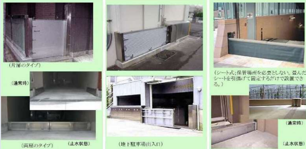
図 24 防水板の種類
