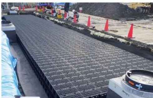
図 11 雨水貯留浸透施設の設置事例(鮫浜小学校)
