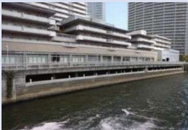
図 34 荏原調節池取水口
