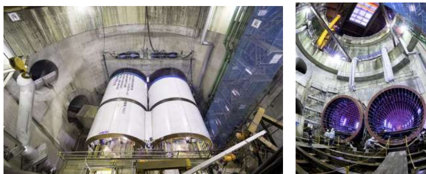
図 41 立会川幹線雨水放流管の施工状況写真
