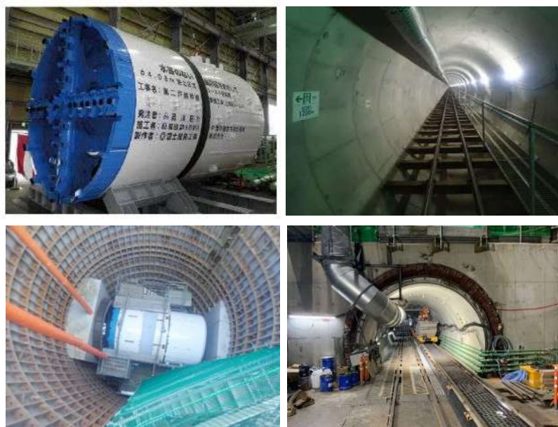
図 17 第二戸越幹線施工中写真
