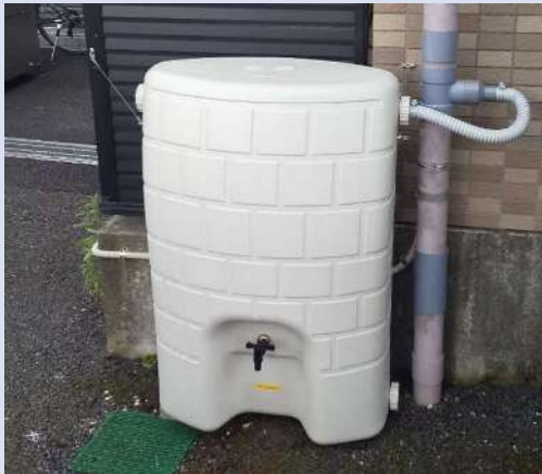
図 13 雨水利用タンク設置イメージ
