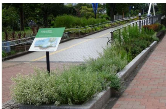
図 4-12 歩道に整備されたレインガーデン (神奈川県横浜市)
