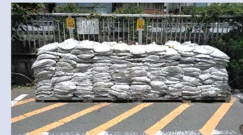
図 3-6 まちづくり対策事例 (土のう置き場)
