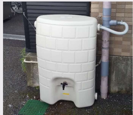
図4-5 雨水利用タンク設置イメージ
