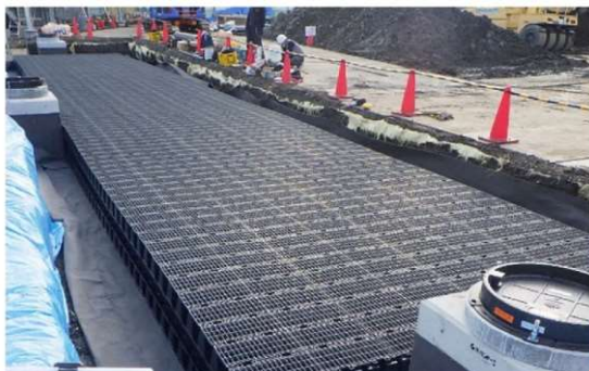
図 4-4 雨水貯留浸透施設の設置事例(鮫浜小学校)
