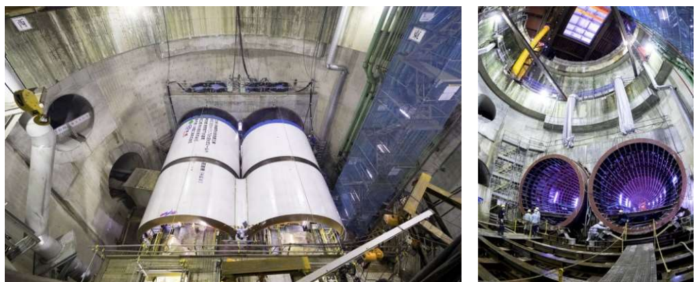
図4-29 立会川幹線雨水放流管の施工状況
