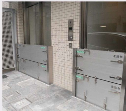
図4-36 防水板設置イメージ
