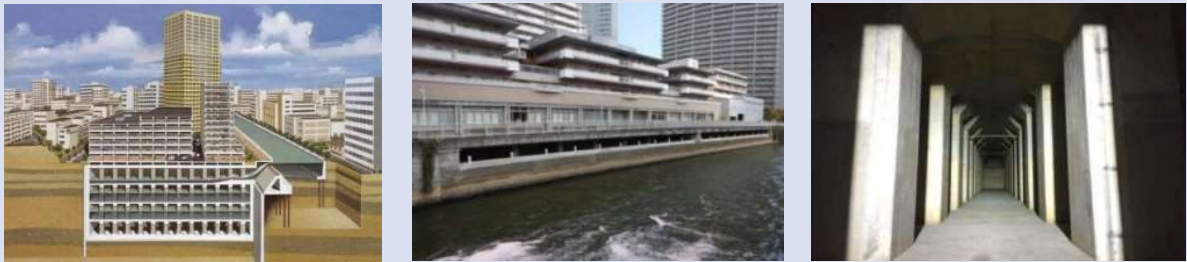
図 3-2 荏原調節池 (左:イメージ図 中:取水口 右:調節池内部)
