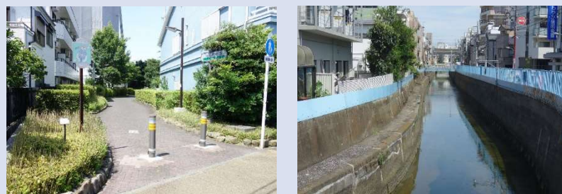
図 3-3 現在の立会川 (左:暗渠区間 右:開渠区間)
