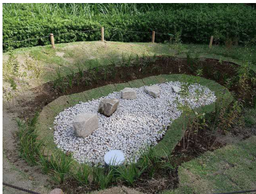
図 4-14 雨庭(レインガーデン)の整備事例 (東京都江東区)
