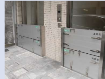
図 3-5 家づくり対策事例 (防水板設置)
