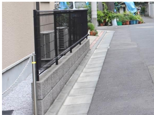
塀・フェンス
