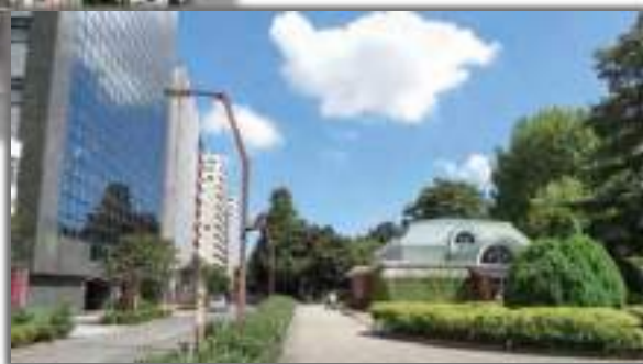
上：新宿御苑トンネル 左：新宿側坑口付近 右：トンネル上部（新宿御苑） 出典：第4回全国街路事業コンクール
