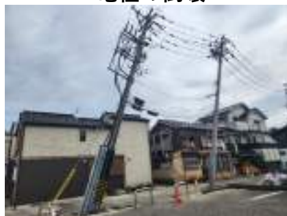
電柱の倒壊
