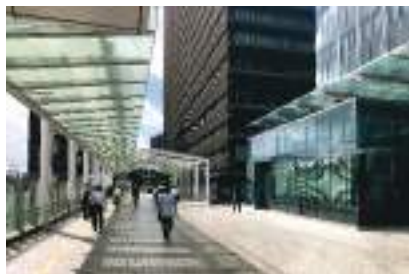
大井町駅西口の歩行者デッキ
