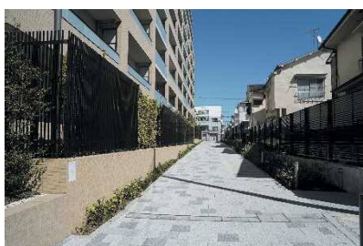
貫通通路スペース
