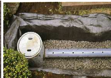
浸透トレンチ
