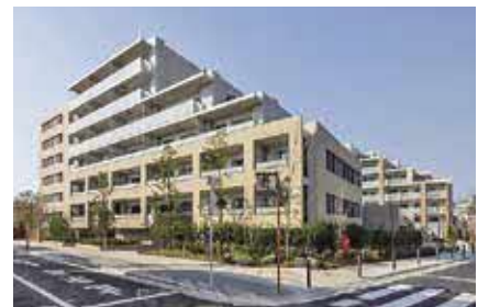
老朽建築物の除却と共同住宅の整備
