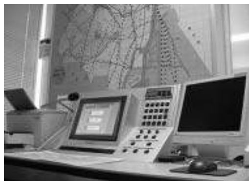
防災行政無線操作盤（品川区防災センター）
