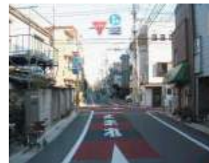
交差点改良 (交差点の色付け・ 停止線前のすべり止め 舗装 戸越5丁目)
