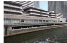
荏原調節池取水部
