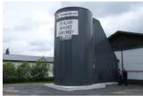
砂を蓄えた熱エネルギー装置
