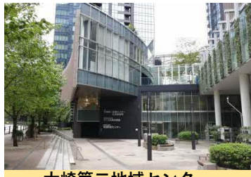
大崎第二地域センター
