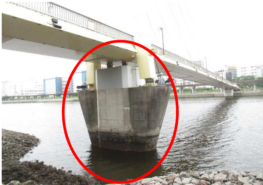
かもめ橋 橋脚
