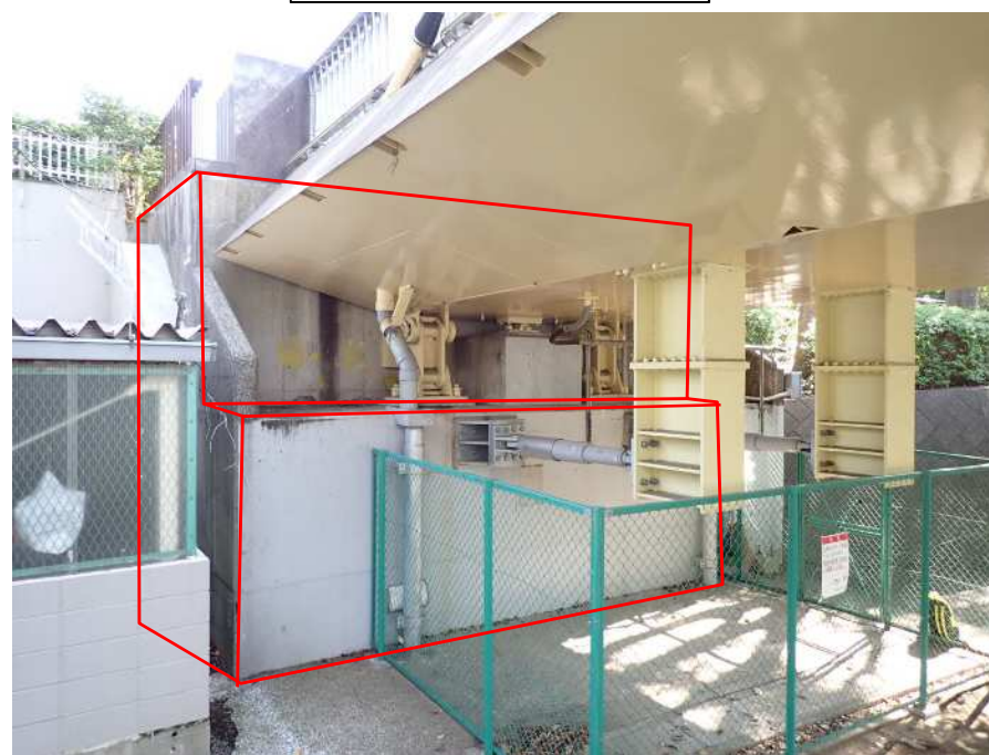
かもめ橋 橋台
