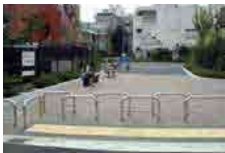
弁天通り公園整備
