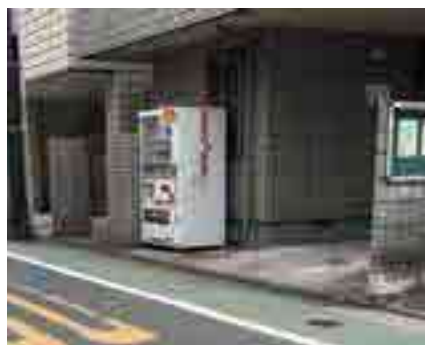
地区防災道路Ⅰ(富士見通り)拡幅整備前
