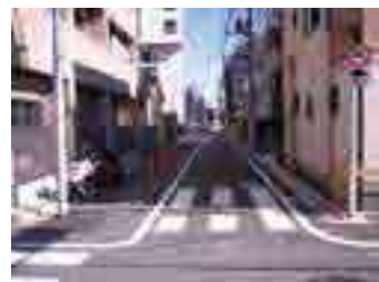
荏原文化センター通り拡張整備
