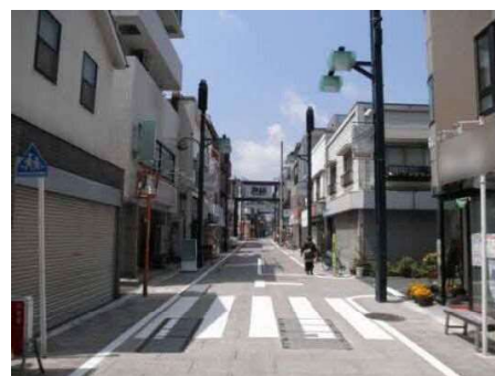
図16 ソフト地中化の例 (戸越銀座通り)
