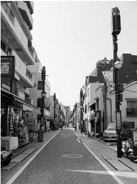
商店街の電線類地中化（北品川地区）
