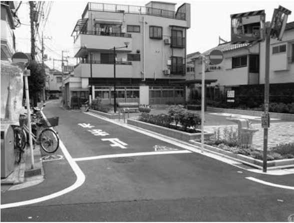
防災広場の整備（二葉中央のんき通り広場）
