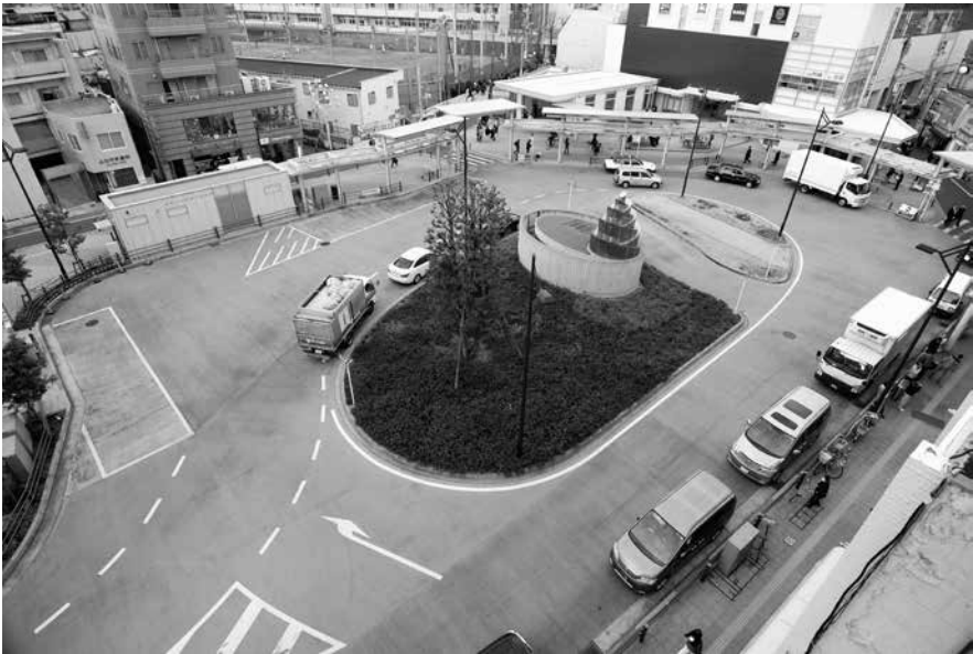
涼のみち（武蔵小山駅前交通広場・遮熱性舗装）
