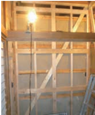
住宅の耐震補強工事
