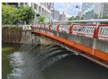
御成橋からの再生水散水の様子
