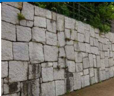
第四台場のあった歴史をイメージさせる、新しく整備した石積み擁壁
