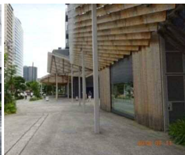
セットバック部分に板状の庇を張りだして、印象的な空間を形成
