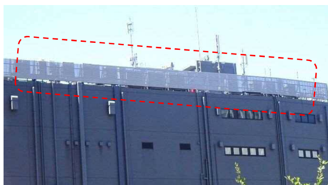
外部に面する建築設備は、景観に配慮してメッシュ素材やルーバーで修景している
