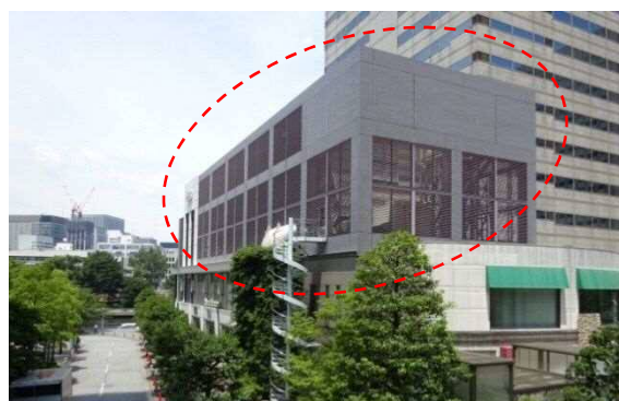
外部に面する建築設備は、景観に配慮してメッシュ素材やルーバーで修景している
