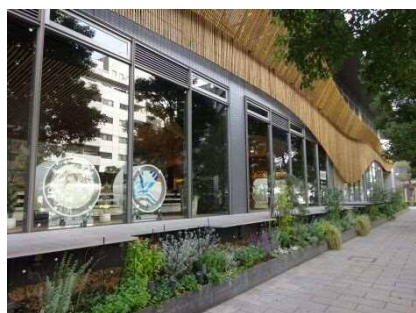
壁面の修景に「竹」を利用してアート感のあるファサードを形成
