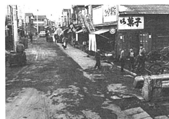
▲同地点工事終了後（昭和29年）
