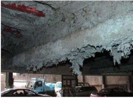
石綿とセメントを一定割合で水を加えて混合し、吹付け加工したものです。
