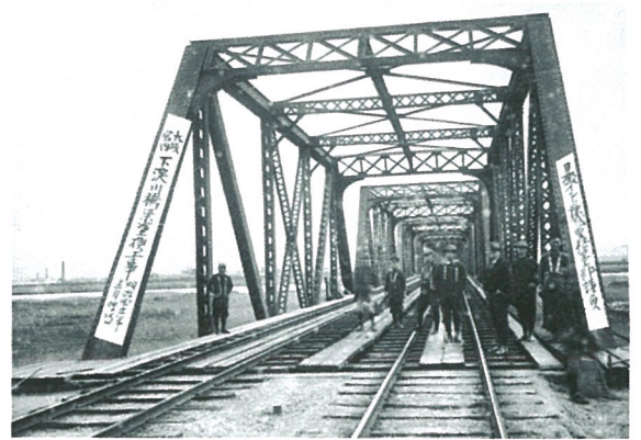
大阪管内下淀川橋梁 明治43年竣工
