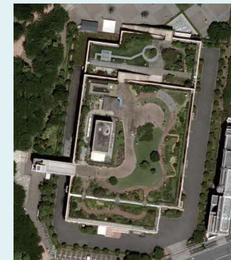
東品川ポンプ所
