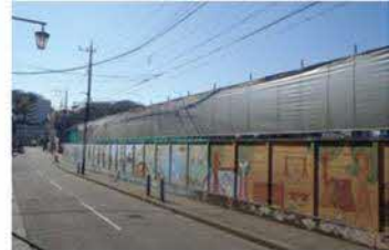
防葉シャッターの整備
