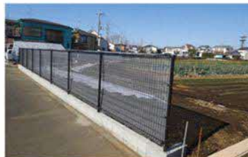
土留め、フェンスの設置
