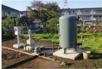
防災兼用農業用井戸の整備
